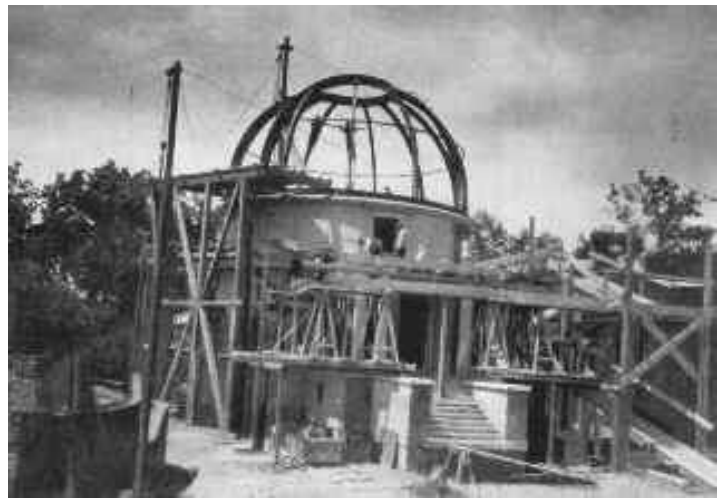
Az épülő kupola 4
